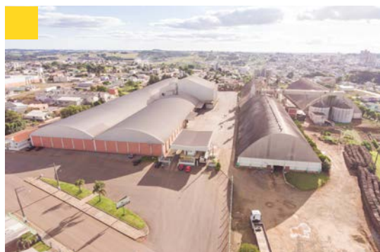
UBS - Bairro Aparecida - Campos Novos/SC
