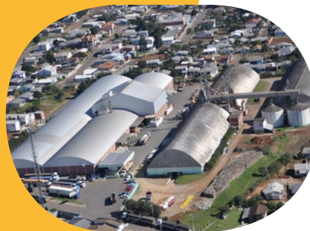
UBS - Bairro Aparecida Campos Novos/SC
