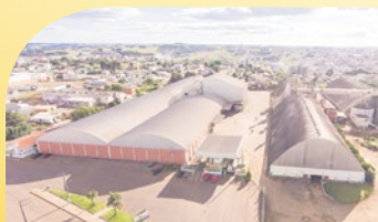
UBS - Bairro Aparecida Campos Novos/SC
